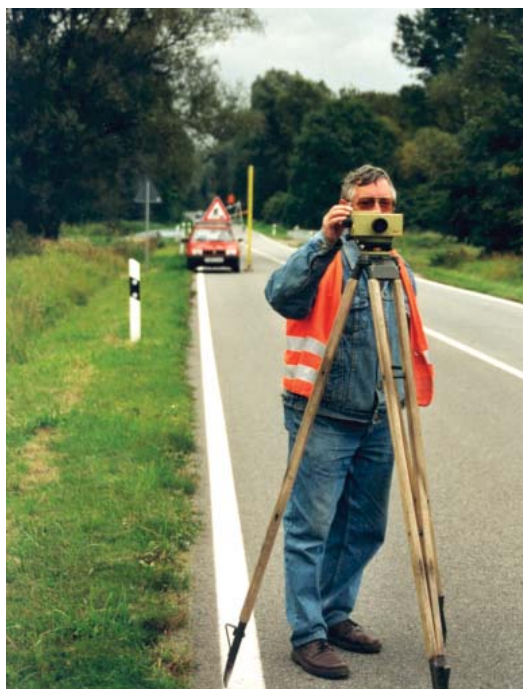
Abb. 15: Teilmotorisiertes Nivellement im Jahr 2000
