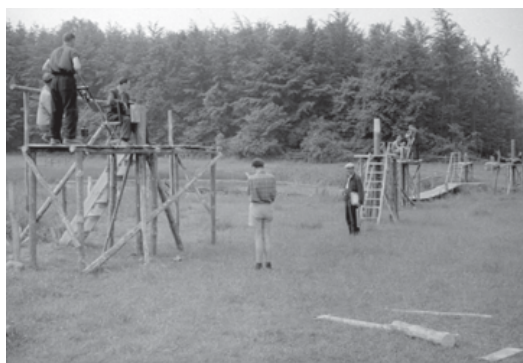
Abb. 12: Basismessung mit Podest 1955/56
