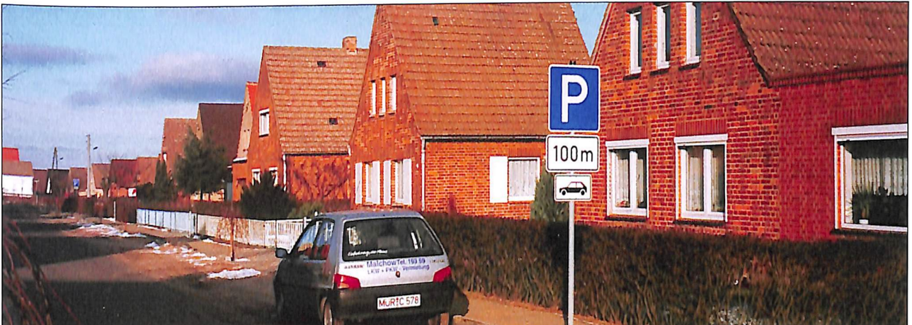
das Baugeschäft Strübing baute von 1937 bis 1942 22 Wohnhäuser in der Trostfeldsiedlung (Foto: Stadtarchiv)
