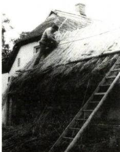
sich, auf einem runden Balken stehend, der mit Tauen an den oberen Dachlatten befestigt ist, Dachlatte um Dachlatte nach oben und verkürzt dabei stets die beiden Tauen.
