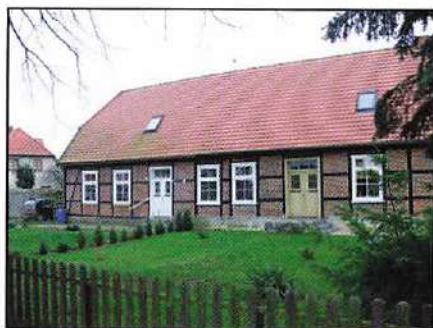
Ältestes Schulgebäude in Dreilützow im Lindenweg (Foto 2006)
