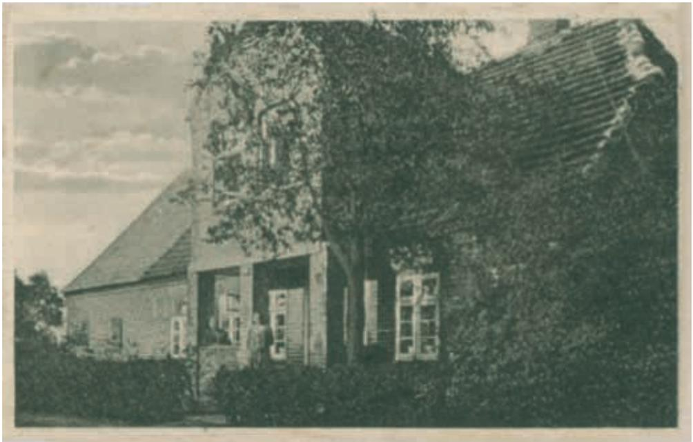
*Das Wohngebäude der Büdnerlei Nr. 11. An hand der unterschiedlichen Dachziegel im hinteren Gebäudeteil ist der an das ursprüngliche Häuslereigebäude angebaute Stallteil gut erkennbar.*
