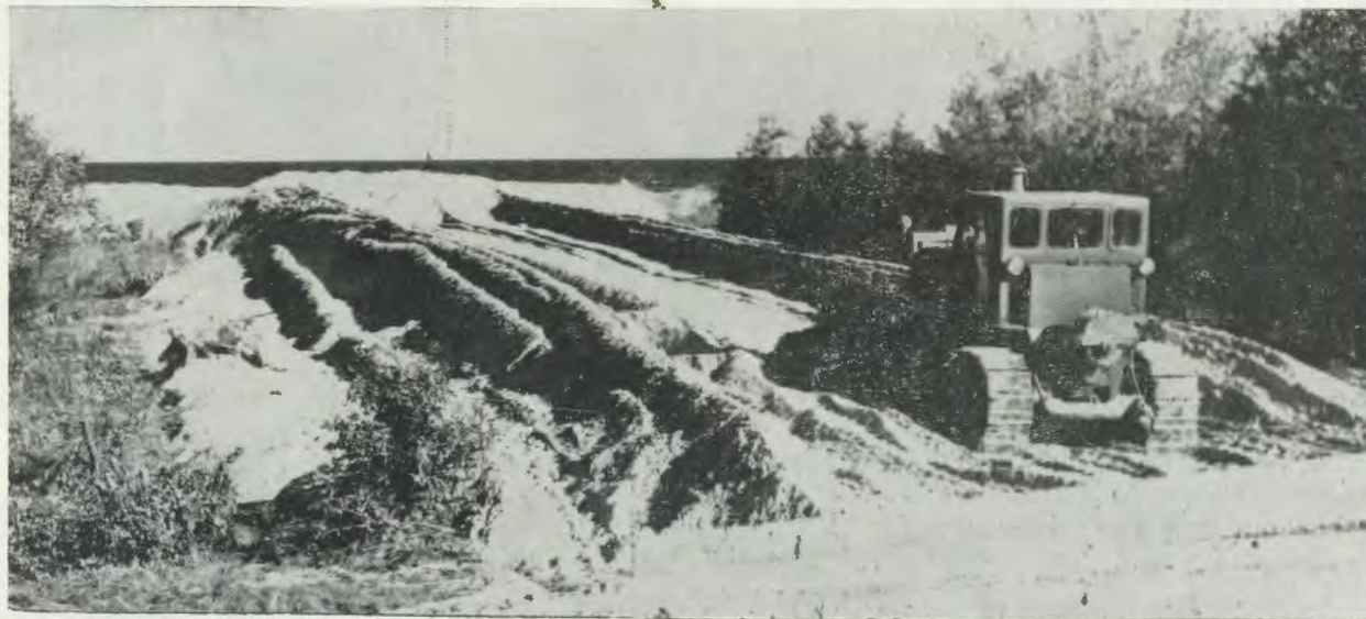
Auch beim Bau neuer Deiche sind in der Vergangenheit große Anstrengungen unternommen worden, die sich in einem besseren Hochwasserschutz auszahlen.
