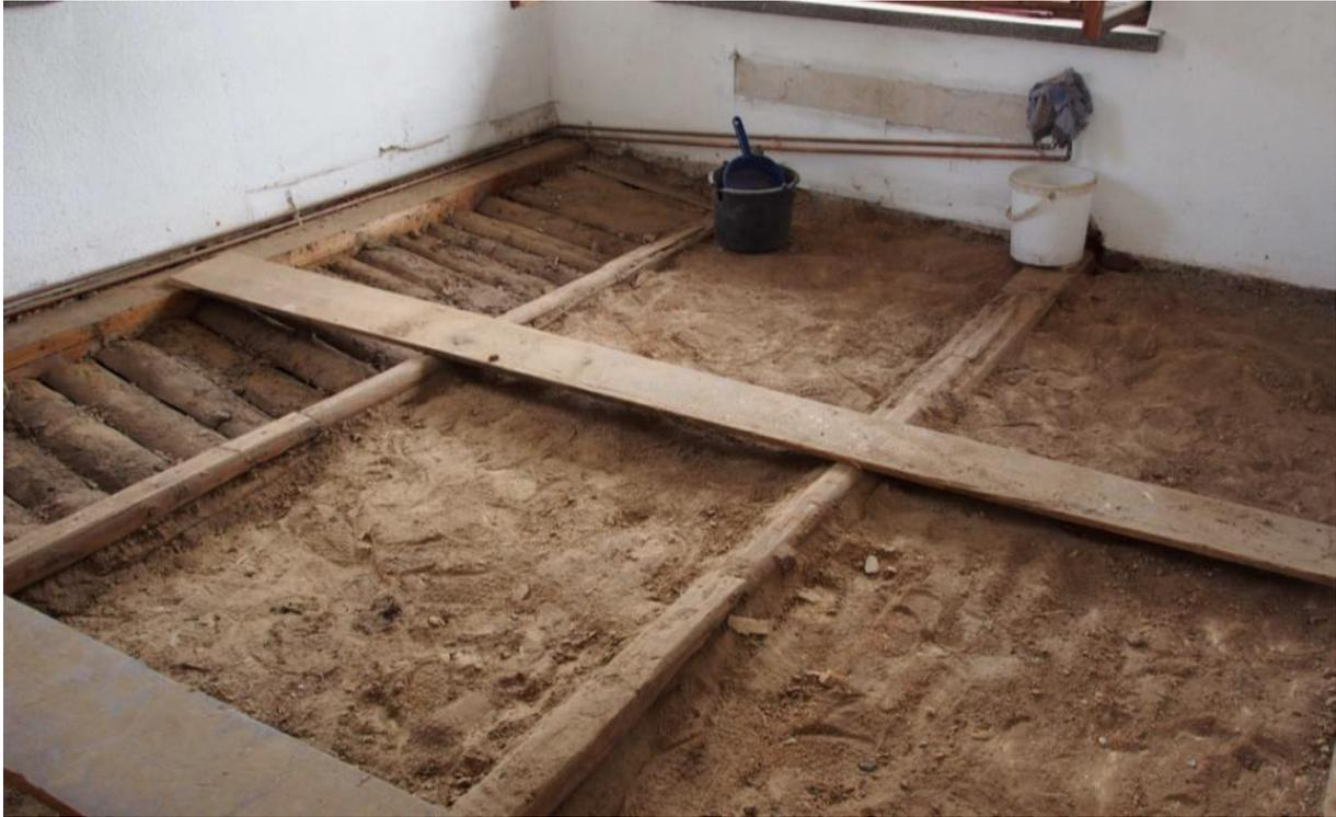
Bild – Internet; Decke über der guten Stube – Die Balken waren auf dem Hausboden sichtbar sichtbar (Stärkere Balken wegen der größeren Spannweite) Die Wickelbögen waren mit Lehm verputzt. Auf den Balken waren teilweise Dielenbretter genagelt. Darüber verlief dann der „Fuchsbau“, die waagrecht gemauerten Schornsteinzuleitung von der Schlafstube zum Schornstein
