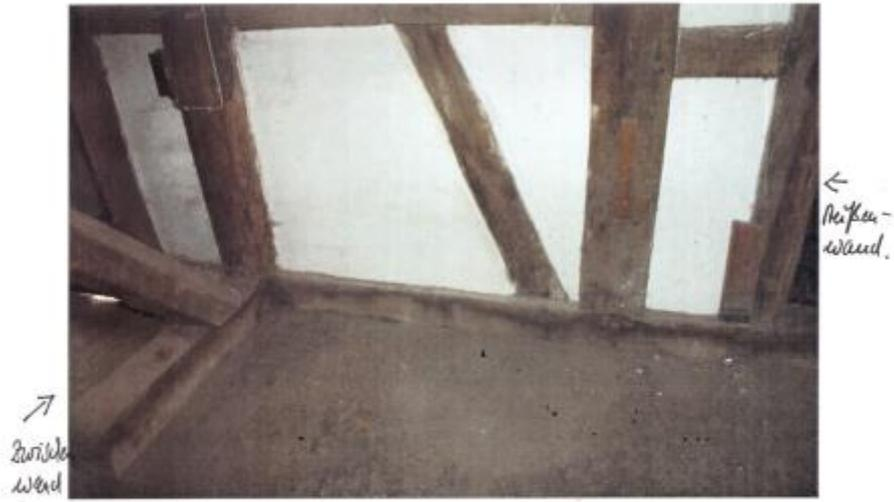
Balkenkonstruktion der Zwischenwand zur Rißenwand.
