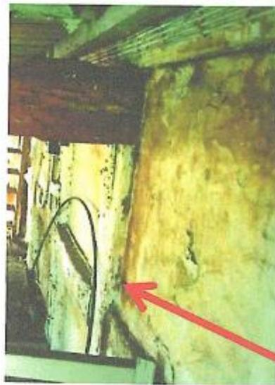
zu erkennen ist, dass der Ständerbalken stärker ist, als die übrigen Balken der Giebelwand und somit aus der Wand hervorsteht. So war dies ebenfalls im Wohnhaus zu finden. Deutlich sichtbar wurde diese Konstruktion auf den Böden an den Giebelseiten.
