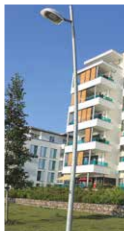
Neubau am Ziegelsee
