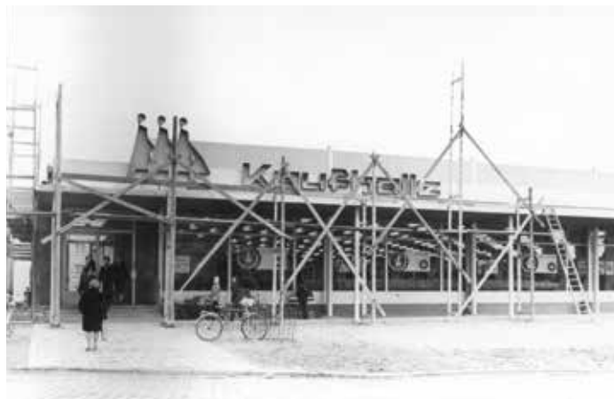
Ab 1955 wurde die Großwohnsiedlung Weststadt errichtet, hier mit der im Bau befindlichen Kaufhalle in der Lessingstraße. Foto: Stadtarchiv
