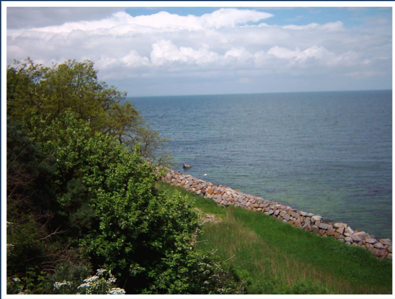
Preußen: 1893 Baubeginn des Steinwalls - bis 1913 – 350 m lang
