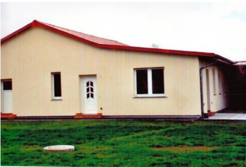
Die KFZ Verwertung Strunk vor und nach dem Umbau zum Wohnhaus.
