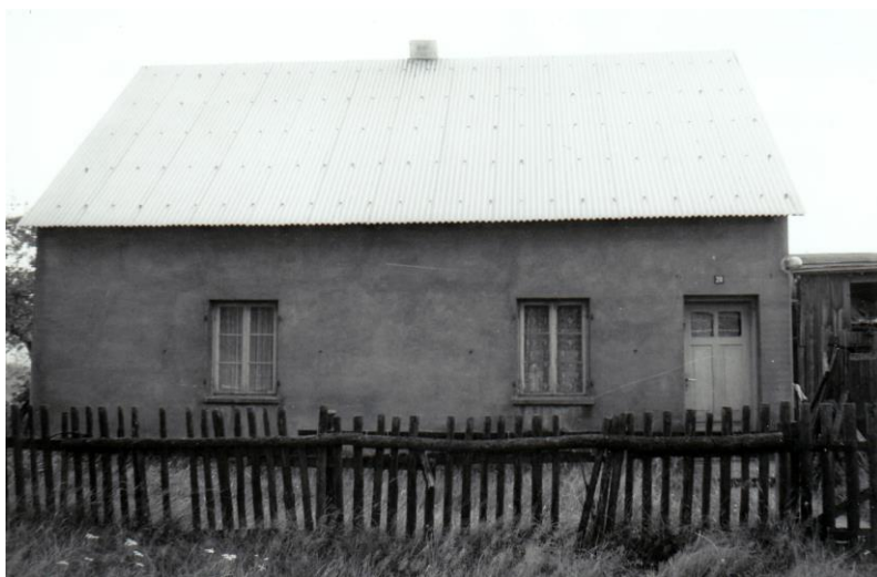
Das Wohnhaus „Leske“ Parchimer Strasse 20, 2007 abgerissen und wieder aufgebaut.
