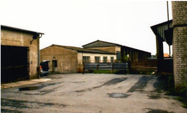
Die Schmiede (links) dahinter das Sozialgebäude und die Maschinenhalle und rechts ein Teil des Heizhauses.
