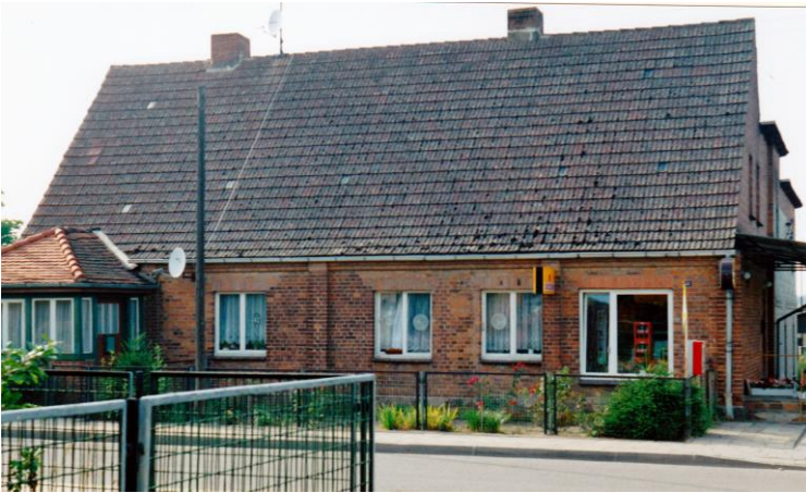
Die Bäckerei nach Umbau 1987 nach den Vorstellungen des Bäckermeisters Gilbert Matlock
