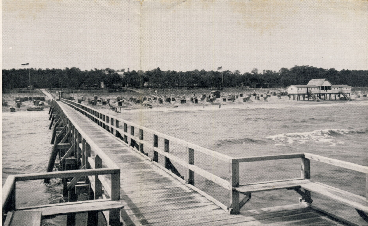
Die Seebrücke, an der die Dampfer anlegen, die von Bad zu Bad die Verbindung auf Usedom herstellen
