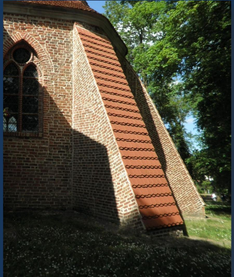
Die Strebepfeiler sind um 1780 entstanden, um den Anbau zu stabilisieren.
