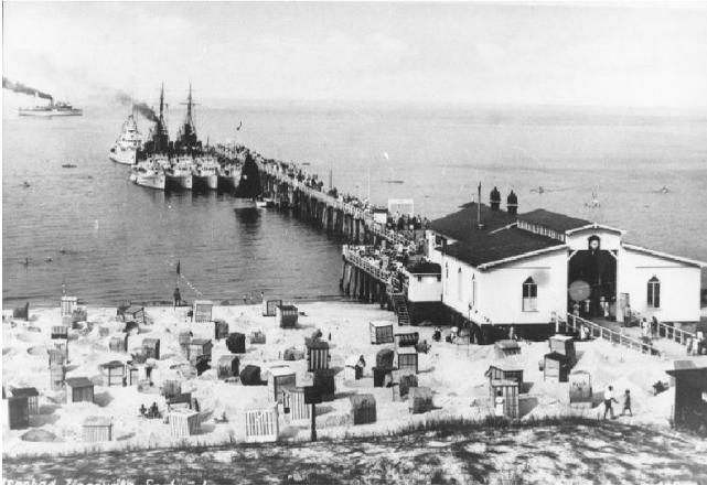
Bei dem Eisschaden im Januar 1940 meldete der Zinnowitzer Bürgermeister dem Versicherungsbüro in Hamburg den Verlust von 8 Pfählen mit einer Länge von 14 m und einem mittleren Durchmesser von 43 cm. Weiter Balken und Eisenzeug wurden abgetrieben, der vorderste Teil der Brücke war stark beschädigt worden. Die Reparatur gestaltete sich sehr schwierig und der Schaden wurde auf 2300 Reichsmark geschätzt.
