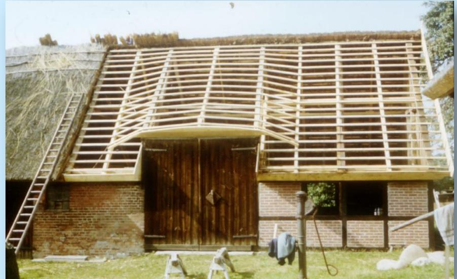
Die Dachlatten und Windbretter werden auf die Sparren genagelt.
