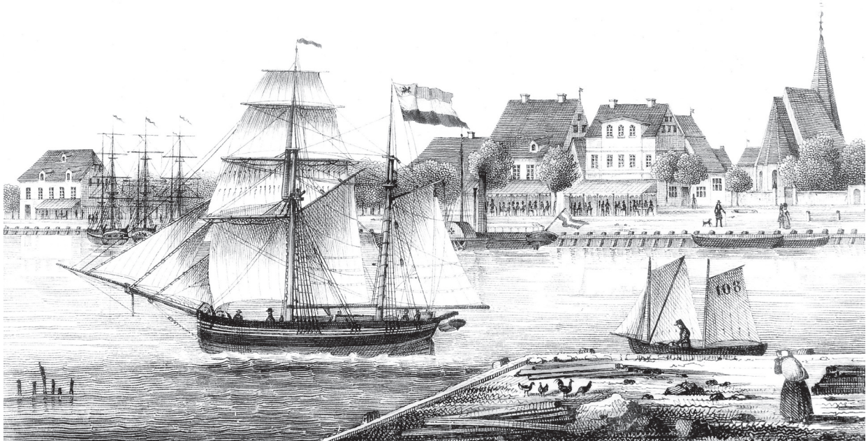
Ein Blick vom Bauhof am östlichen Warnowufer auf das Zentrum von Warnemünde ungefähr zur Zeit der zweiten Volkszählung im Jahre 1867. Rechts im Bild steht die alte Fischerkirche. Die großen Gasthöfe und auch die Vogtei haben zur Straße hin überdachte Bereiche für ihre Gäste.
