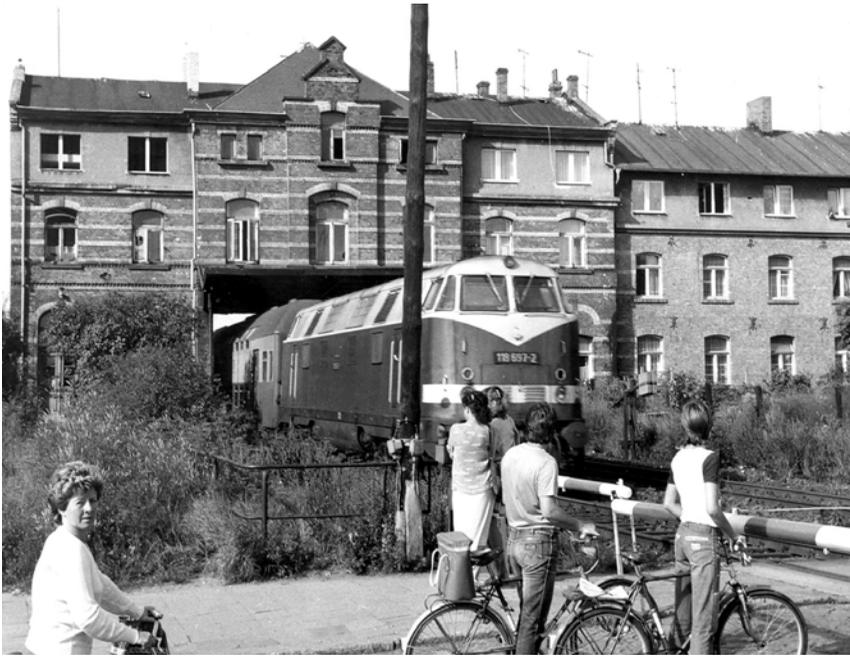
*Nach 1903 hatte der alte Bahnhof für den Personenverkehr ausgedient. In der Mitte durchbrochen wurde er nun zum Tunnel für die Züge, die zum neuen Bahnhof fuhren.*
