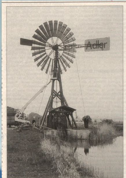
Mit einem größeren Kran gelang es gestern, das Rad auf das Kachliner technische Denkmal zu setzen. Kurierfoto: Reißerweber
