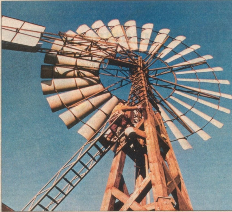
Angeseilt wie ein Bergsteiger schwingt Gerd Kilter den Pinsel. Um dem Kachliner Windkraftschöpfwerk einen Holzschutzanstrich zu verpassen, benutzen die Mitarbeiter des Bauhofes einen Multicar mit Leiter. Foto: jobe
